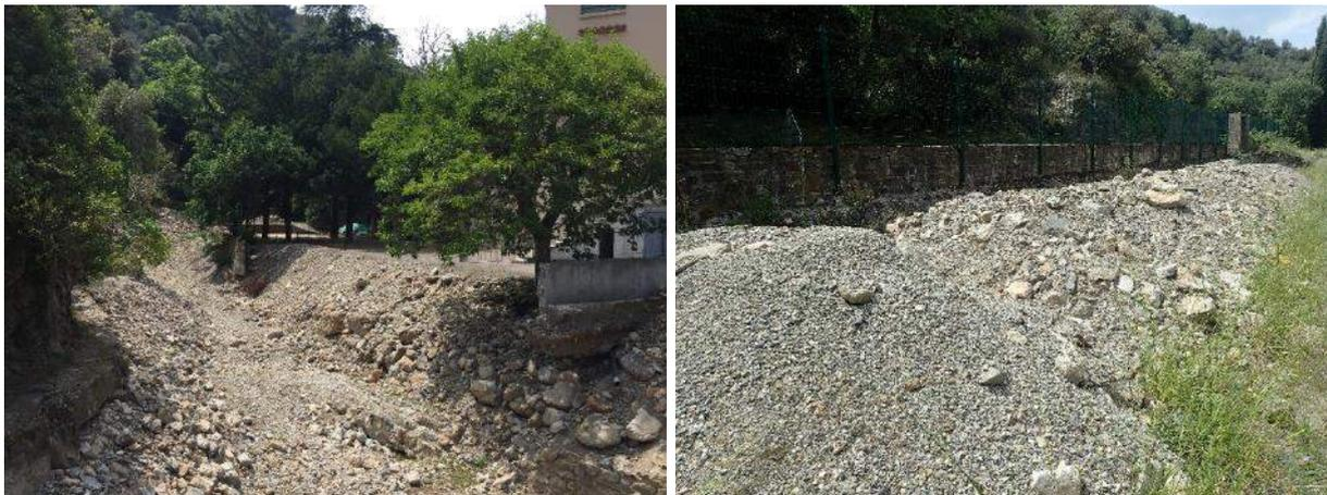
*Illustration 8 – Photographies de l'ancienne digue de protection de la cour d'école de Lastours emportée par l'inondation et remodelée (à gauche) et du stockage des sols décapés (à droite)*
